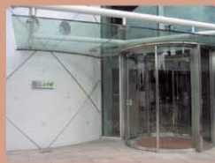
▲新局舎の入口
